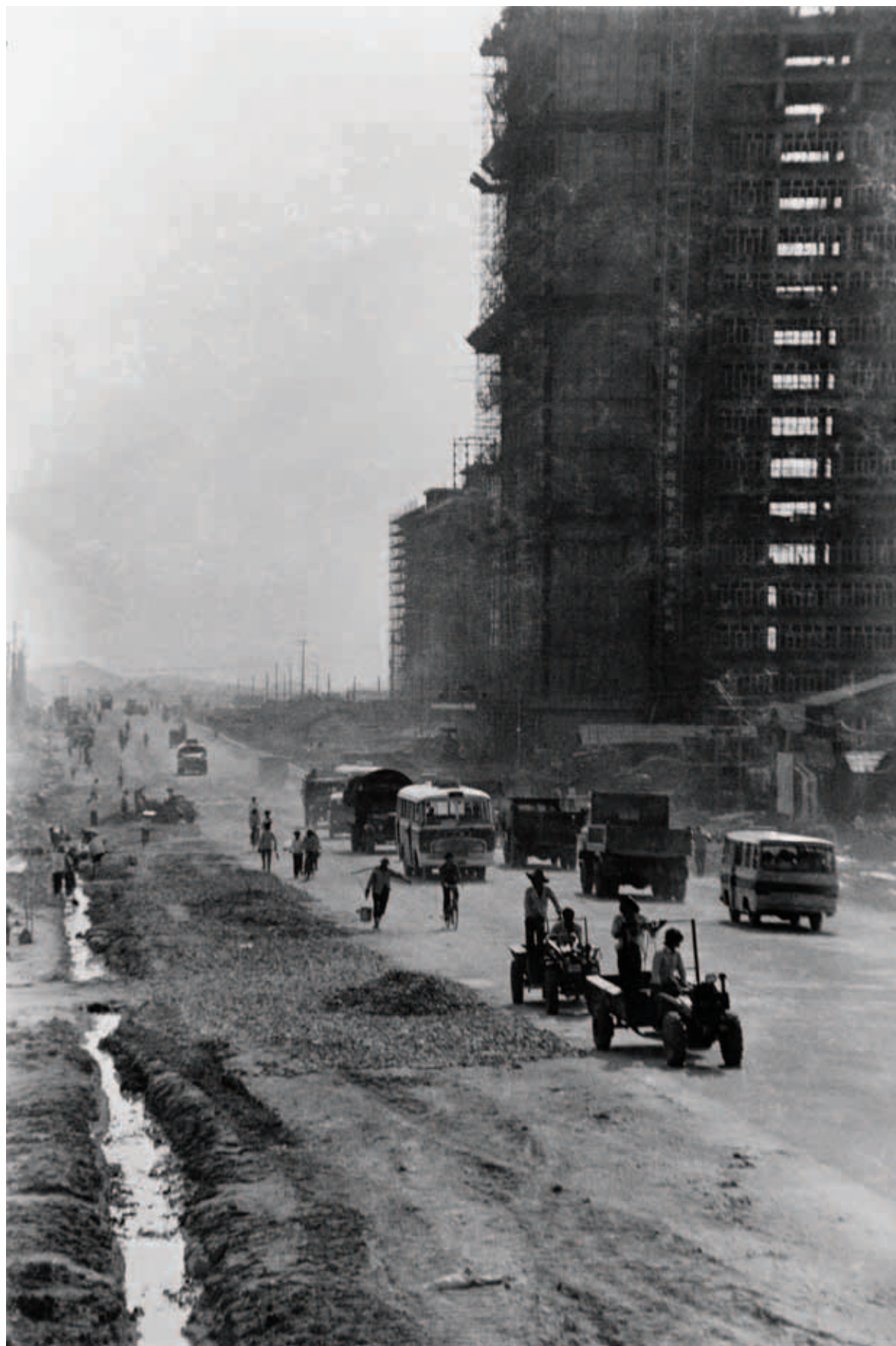
1982 年的深南大道。图为施工中的深圳第一栋高层建筑“电子大厦”，由基建工程兵承建 / 江式高 摄
