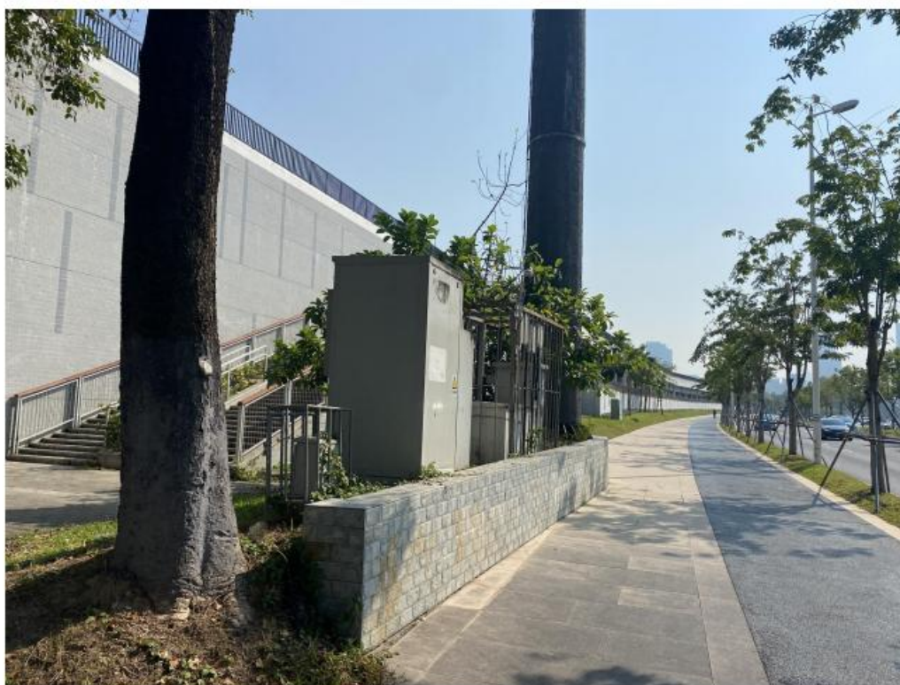
图 6-11 滨海大道梯道处改造前
