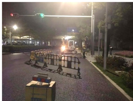
紧急性占道作业、道路及设施养护
